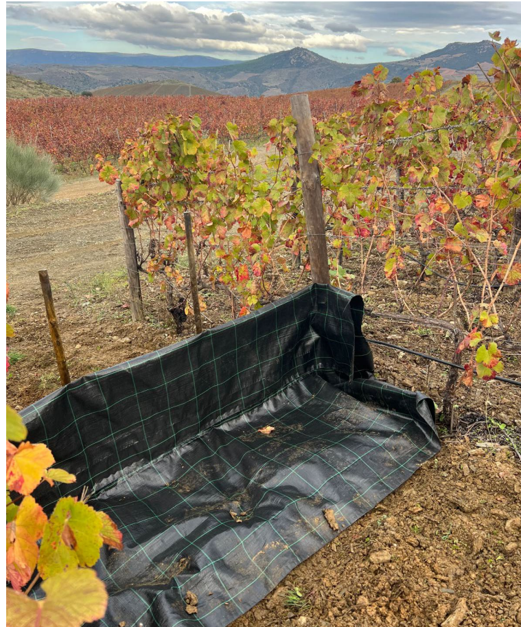
Instalación de tela para retención de suelo
